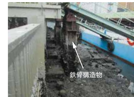
柱脚PX8列と鉄骨構造物
