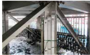
図1-1 柱脚X7Y2の取り付け状況
