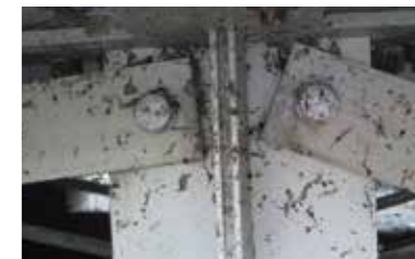
鱗片状亜鉛積層エポキシ樹脂塗装処理が施されたステンレス鋼六角ボルト。
