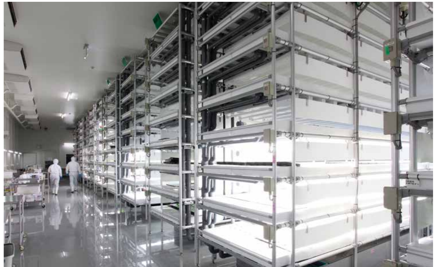
大型のGF製栽培棚が並ぶ工場内。半導体事業で培ったクリーンルームの管理技術を空調設備などに生かしている。
