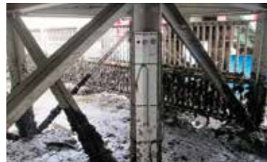
図1-2 柱脚X7Y3の取り付け状況
