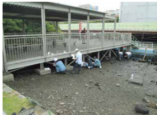
浜離宮恩賜庭園船着場・棧橋調査の様子
