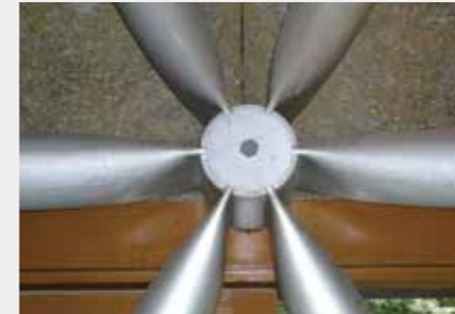
アルミパイプの接合には嵌合という手法が使われている。
