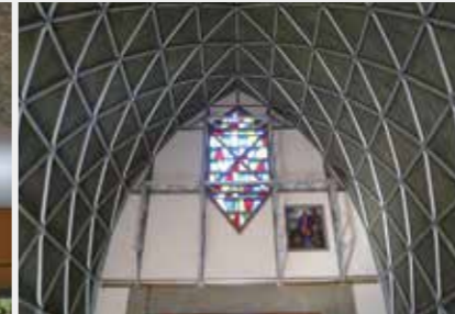
アルミパイプを用いたシェル構造がアーチ型の内部空間を形づくる。
