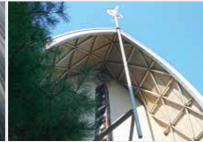
軒天部にも目立った腐食は見られない。
