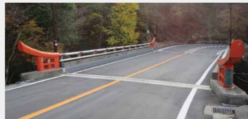
(上) 道路面から見た金慶橋。 (中) アルミ桁の側面に腐食は見られない。 (下) 腐食の発生しやすい軒天部分も黒斑状の微少点食が散在する程度。 写真提供: 日本アルミニウム協会
