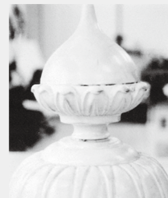
アルミ铸件製キャップ (底部の直径335mm、高さ350mm、厚さ5mm)
