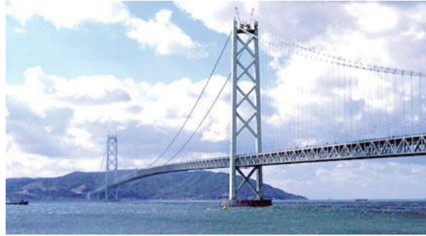
明石海峡大橋のメインケーブルには180kgf/mm 2 級鋼線が使われています (従来材は160kgf/mm 2 級鋼線)
